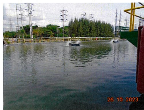
ภาพที่ 2-33 บ่อน้ำดับเพลิงสำรอง (Fire Pond)
