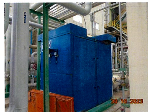
ภาพที่ 2-8 ผนังกันเสียงบริเวณเครื่องจักรที่เป็นแหล่งกำเนิดเสียงดังมากกว่า 85 เดซิเบล(เอ)
