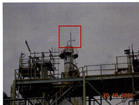
ภาพที่ 2-22 ระบบป้องกันฟ้าผ่าและสายดิน
