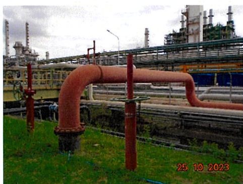
ภาพที่ 2-32 ท่อรับน้ำดับเพลิง
