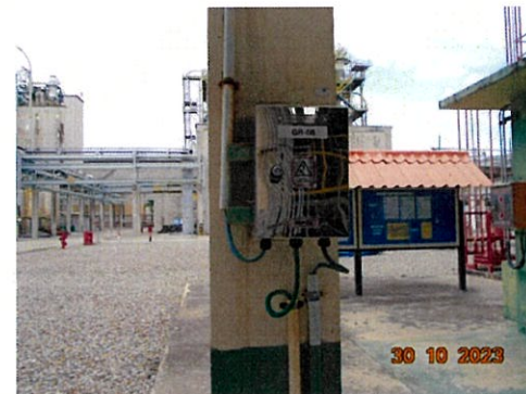
ภาพที่ 2-22 ระบบป้องกันฟ้าผ่าและสายดิน
